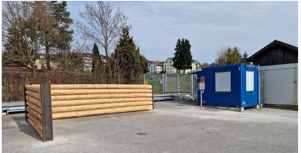
Im Hintergrund sind die Fahrzeugwaage und das blaue Waagehaus zu sehen. Im Vordergrund die Holzwand für den Abladeplatz der Kleinmengen-Waage und vor dem Waagehaus die versenkte Kleinmengen-Waage. Foto: zVg
